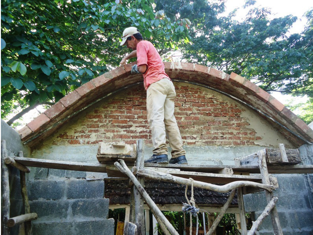
Figura 13. Campesino construyendo un techo de bóveda con ladrillos fabricados en la comunidad.
