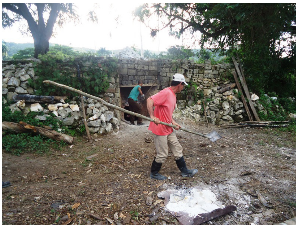
Figura 14. Confección de un horno de cal.
