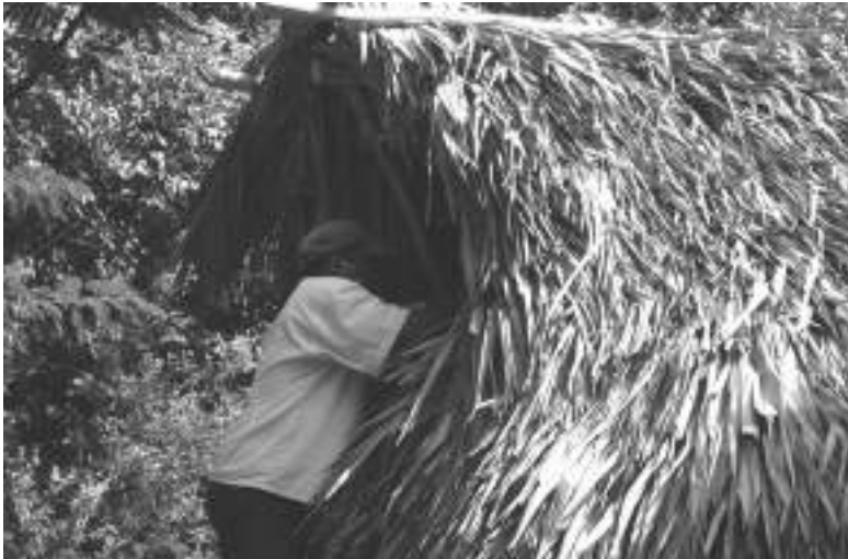
Figura 19 Socio de U Najil Ek Balam que repara el techo de palma de una cabaña
